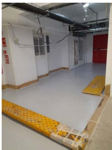
Reforma de la cocina de empleados. Planta Sótano 1. Sustitución de techos, cambio de iluminación fluorescente por LED. Cambio de desagües y sumidero para baldeo de agua de limpieza. Reordenación conducciones abastecimiento de agua. Cambio de solado existente por baldosa porcelánica antideslizante tipo C. Reordenación de zona de cocina y preparación, cambio de electrodomésticos, campana extractora y encimera de preparación:
