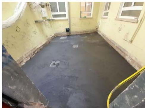
Rampa de acceso a zona de almacenes desde patio de servicio. Planta Sótano 2. Rampa de hormigón armado, acabado en pintura epoxi, incluida valla de protección contra caídas a distinto nivel:
