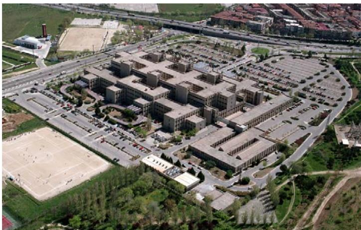
El Edificio Principal, de 68.036,90 m<sup>2</sup>, se construyó mediante una estructura modular basada en la unidad de Enfermería de tipo “cruz griega”, en la que cada módulo se acopla horizontalmente permitiendo patios ajardinados y chimeneas interiores para conseguir luz natural a todos los espacios, creándose además una “entreplanta técnica” entre cada piso para facilitar reparaciones y las instalaciones técnicas.
