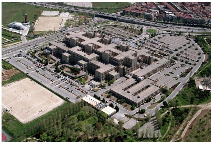
El Edificio Principal, de 68.036,90 m<sup>2</sup>, se construyó mediante una estructura modular basada en la unidad de Enfermería de tipo “cruz griega”, en la que cada módulo se acopla horizontalmente permitiendo patios ajardinados y chimeneas interiores para conseguir luz natural a todos los espacios, creándose además una “entreplanta técnica” entre cada piso para facilitar reparaciones y las instalaciones técnicas.
