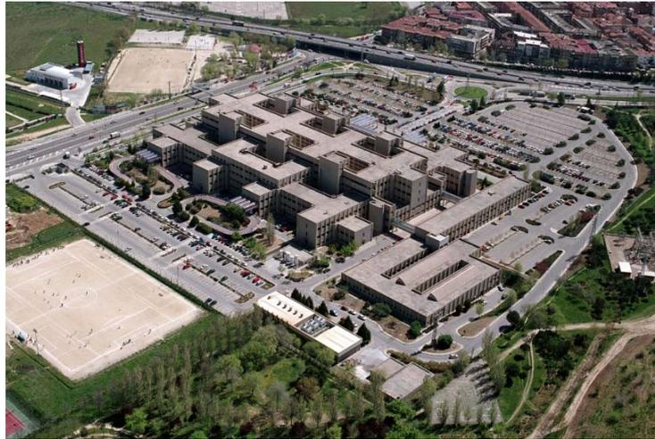
El Edificio Principal, de 68.036,90 m<sup>2</sup>, se construyó mediante una estructura modular basada en la unidad de enfermería de tipo “cruz griega”, en la que cada módulo se acopla horizontalmente permitiendo patios ajardinados y chimeneas interiores para conseguir luz natural a todos los espacios, creándose además una “entrepanta técnica” entre cada piso para facilitar reparaciones y las instalaciones técnicas.
