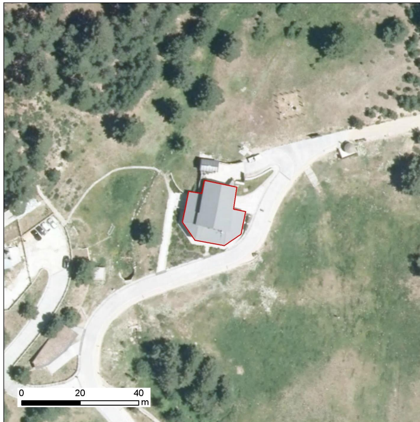
FOTO AÉREA DE LA INFRAESTRUCTURA
