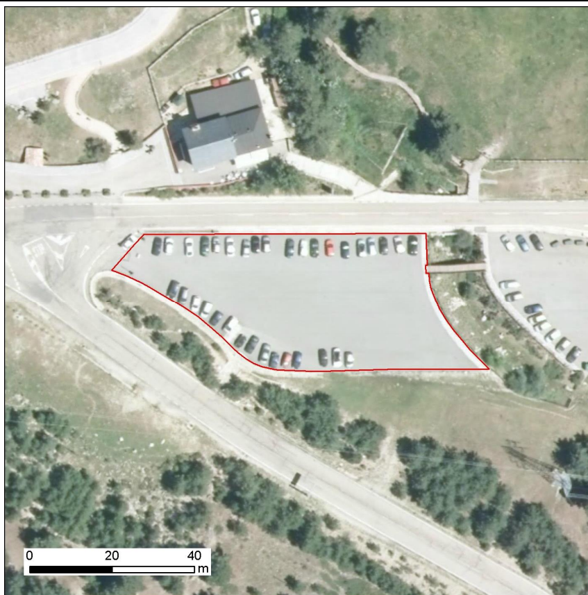
FOTO AÉREA DE LA INFRAESTRUCTURA
