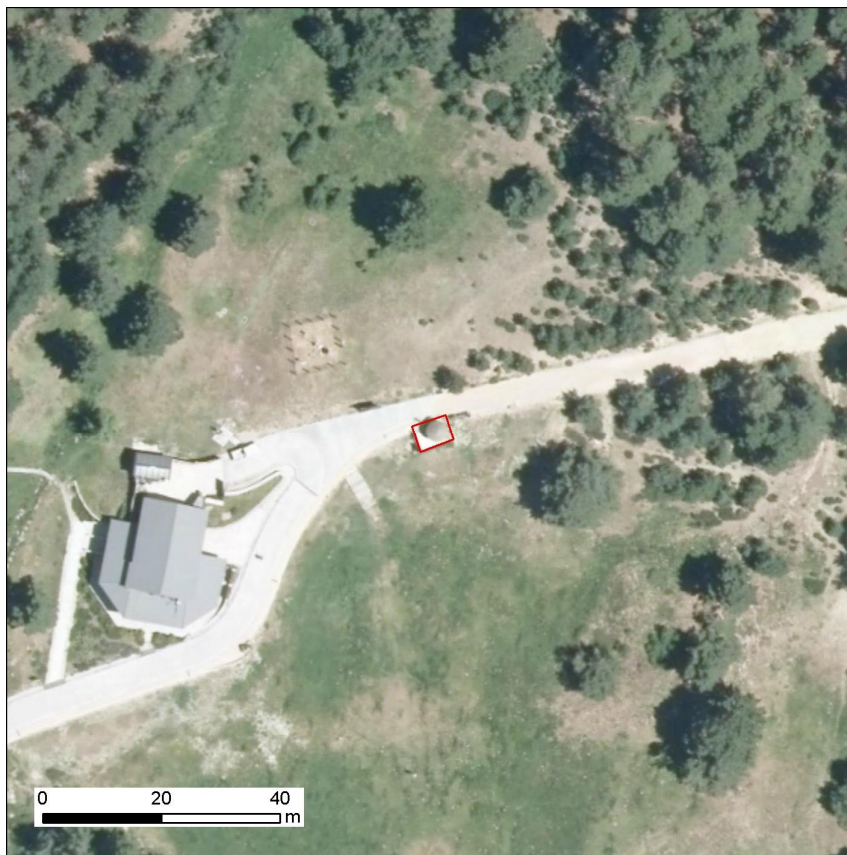
FOTO AÉREA DE LA INFRAESTRUCTURA
