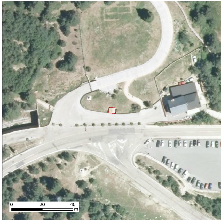
FOTO AÉREA DE LA INFRAESTRUCTURA
