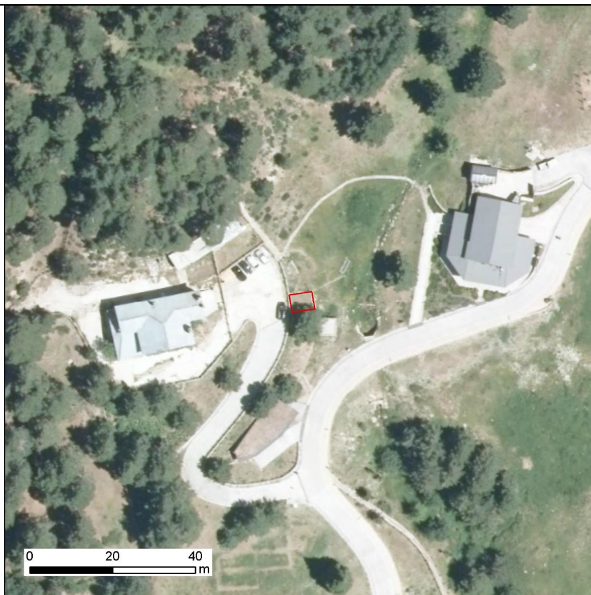
FOTO AÉREA DE LA INFRAESTRUCTURA
