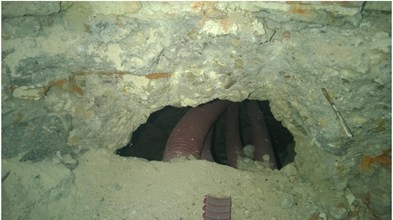
Cámara sanitaria bajo Púlpito.
