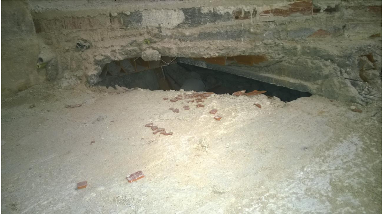
Cámara sanitaria debajo de Púlpito.
