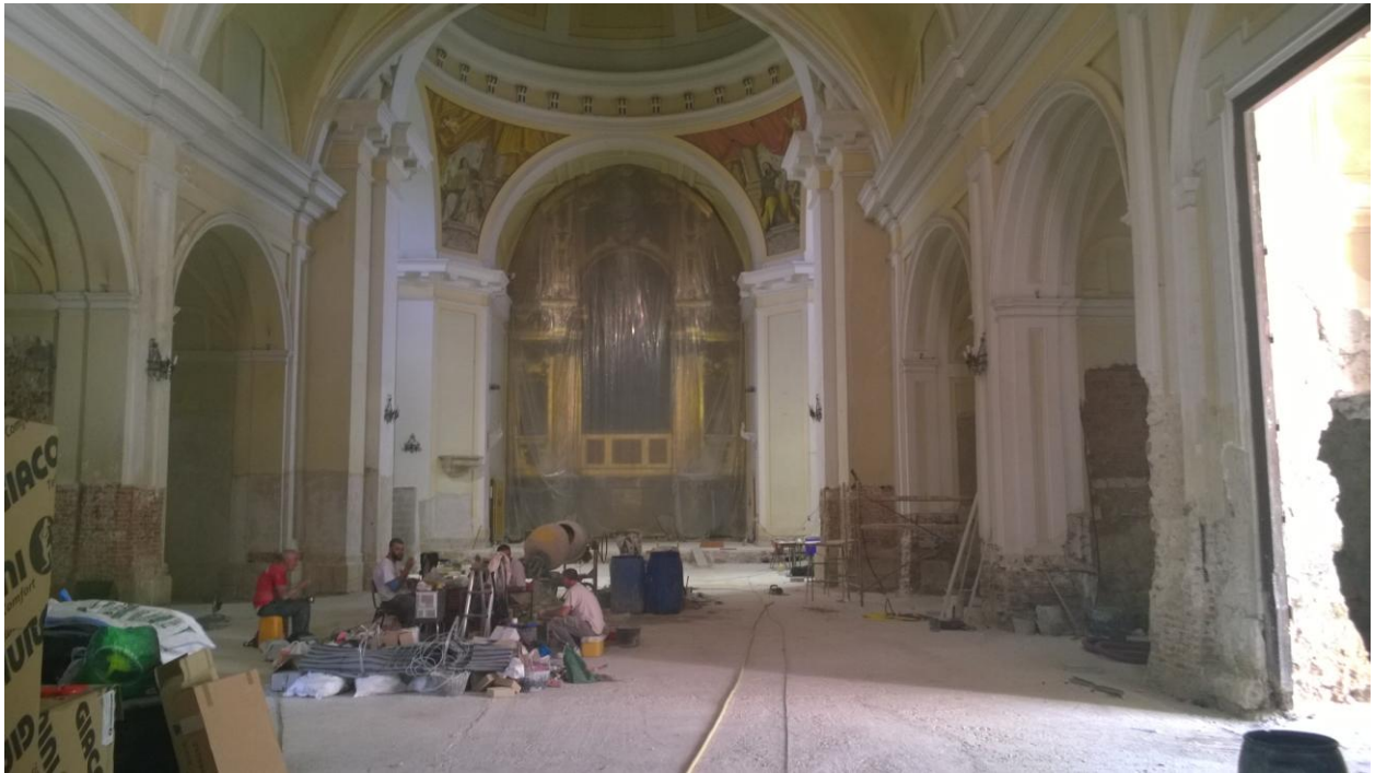
Interior desde nave central hacia crucero .
