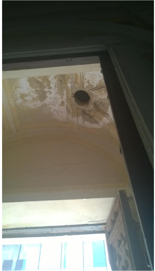
Abertura en muro y bóveda para paso de instalaciones
