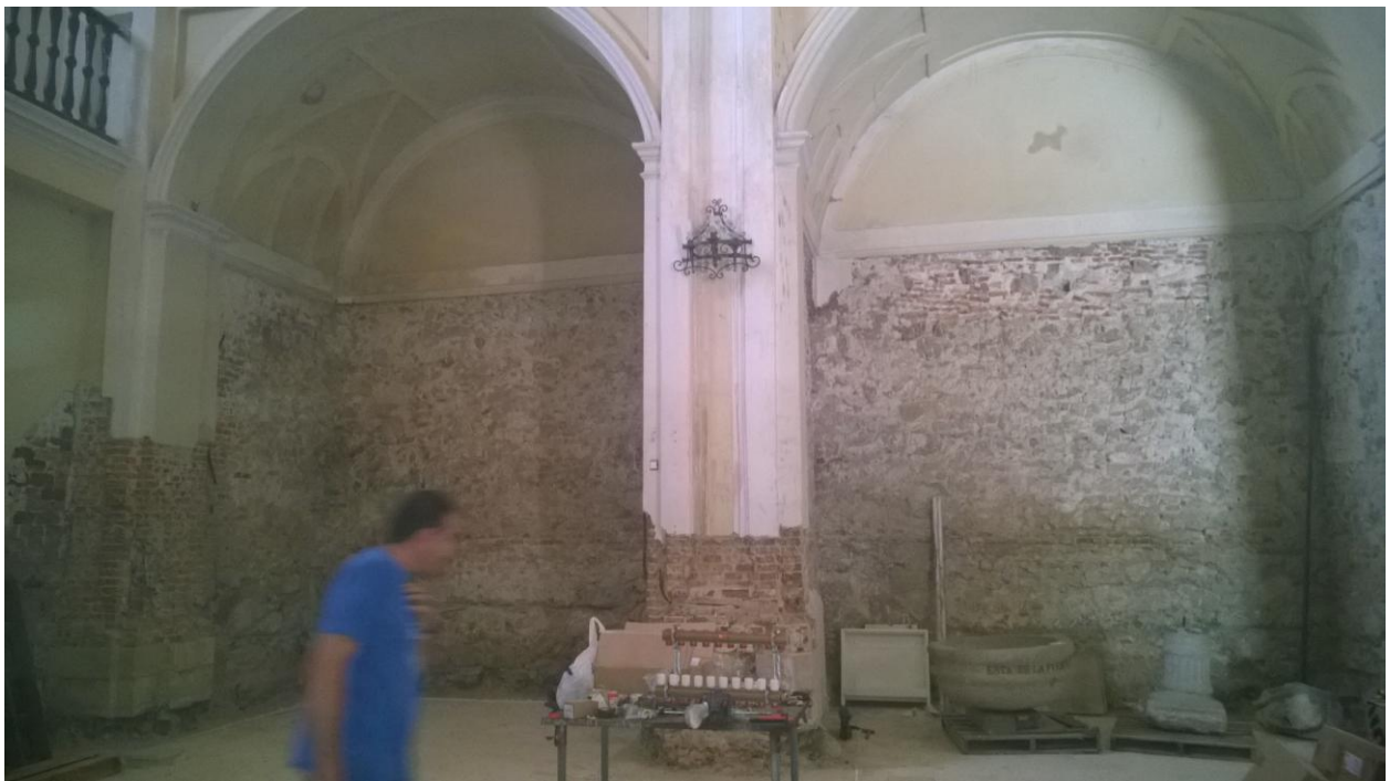
Paramentos interiores con revestimiento de mortero de cemento saneados.
